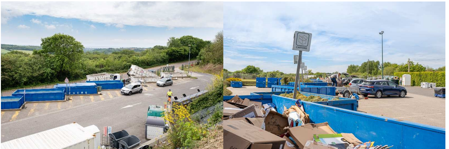
Déchèteries des Moitiers d'Allonne et de Valognes - ©Thierry Houyel
