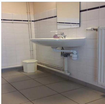
Siphon décentré et miroir abaissé
