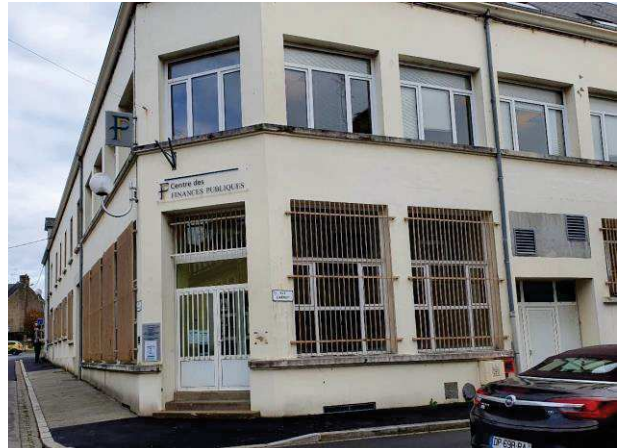
L'Hôtel des impôts occupé jusqu'en juin 2020 par les services de la DDFIP
