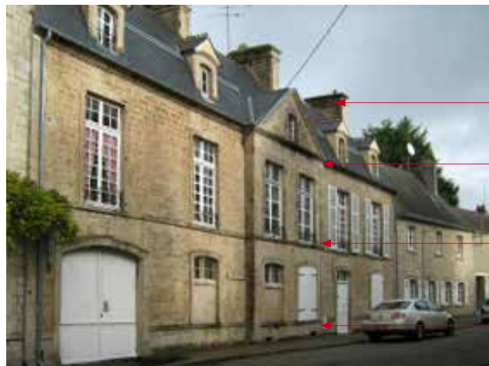
Façade à faux avant-corps et à cinq travées
