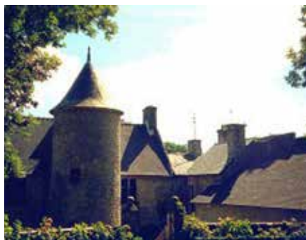
Façade postérieure et tour d'escalier circulaire (vestiges du XVI e siècle). La façade comporte également d'autres vestiges du XVI e et du XVII e siècle.
