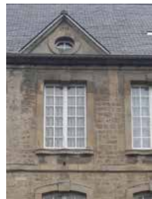
Motif ondulant des appuis. Hôtel de Carville. 1778. 45, rue de Poterie.
