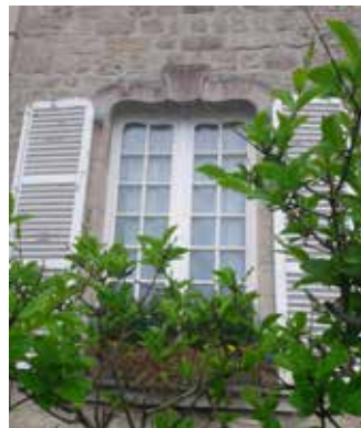
Motif ondulant des linteaux. Hôtel de la Louvière. 1774-1776. 25, avenue Buhot.
