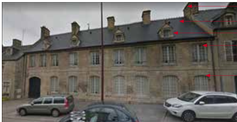
Façade à huit travées et entrée porche latéral
