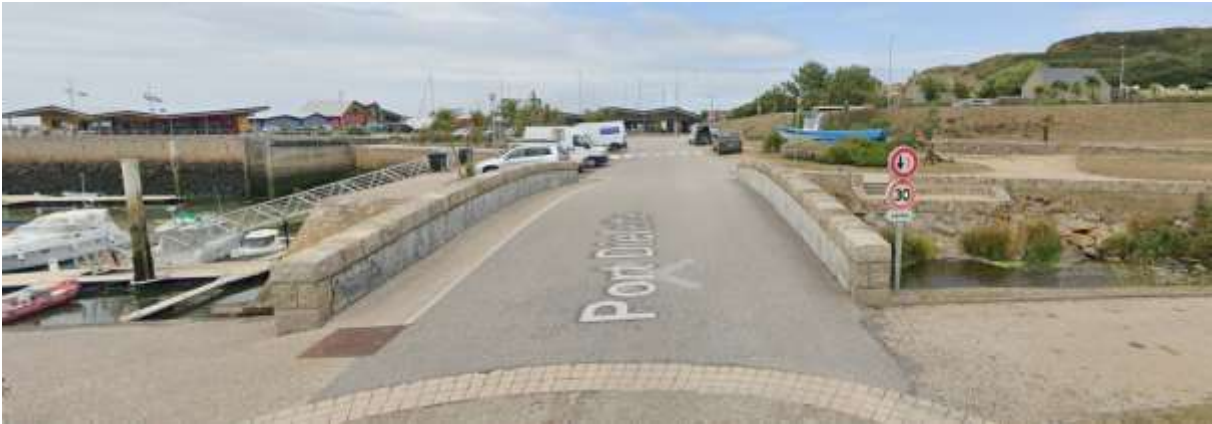
Figure 1 : Vue du pont (lieu d'implantation de la nouvelle station) en arrivant dans le port de Dielette (source : Google Maps)
