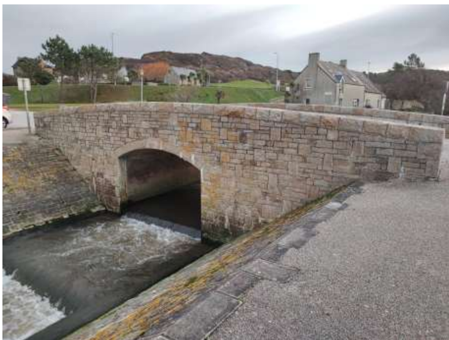
Figure 4 : Vue du pont (lieu d'implantation de la nouvelle station) depuis l'aval
