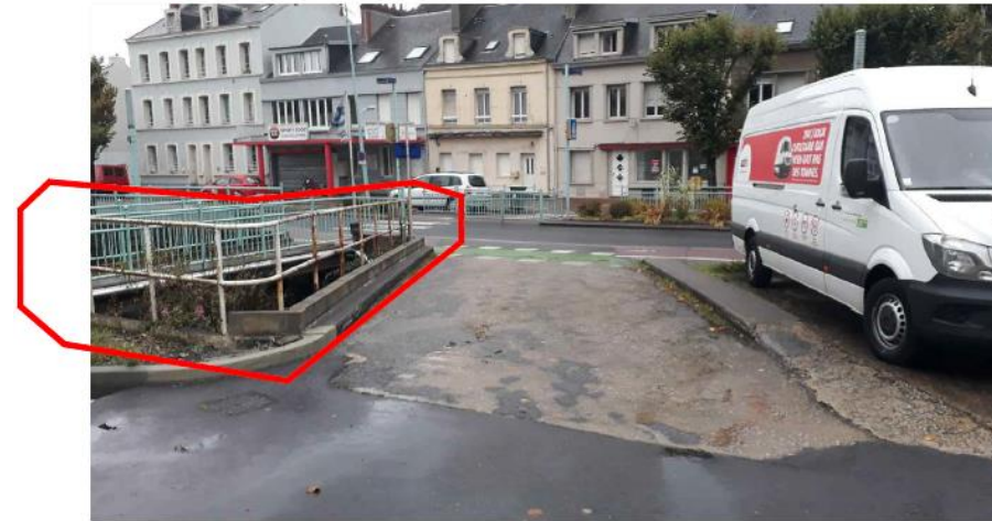
Section DD : pont du 12/14 - 2 garde corps
