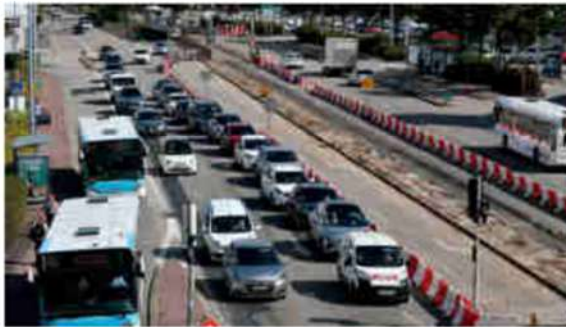
→ Les travaux se dérouleront au niveau de l'entrée du parking SNCF.
