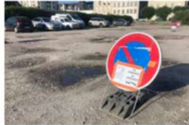
→ À Cherbourg, le parking du quai Lawton-Collins va servir pendant deux ans de base de vie pour le chantier du bus nouvelle génération.
