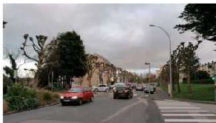
→ Axe fréquenté, l'avenue de Bremerhaven, dans le quartier du Maupas, sera rénovée du 7 au 18 février.
