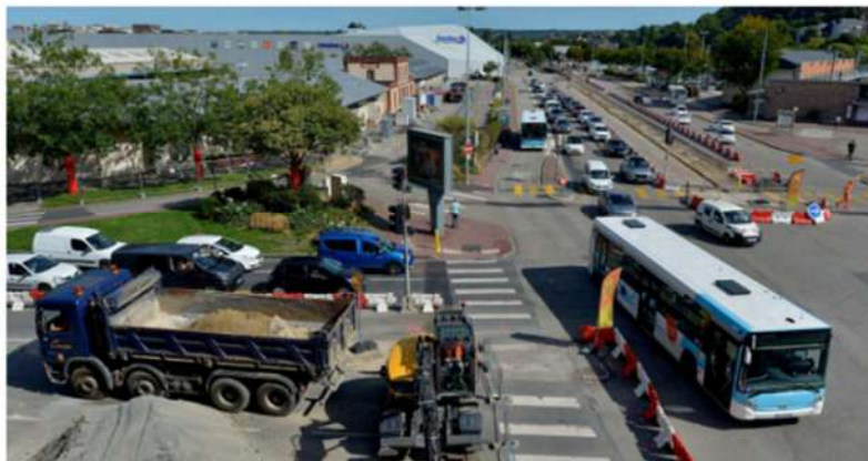
→ Les travaux permettant la circulation du bus nouvelle génération ont débuté le lundi 5 septembre et dureront jusqu'en 2024.
