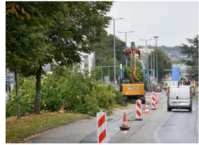
→ Avenue de Cessart. Du 5 au 7 septembre : travaux préparatoires. Du 6 septembre au 21 novembre : travaux côté sud, trottoirs refaits aux normes PMR, création d'espaces verts.
