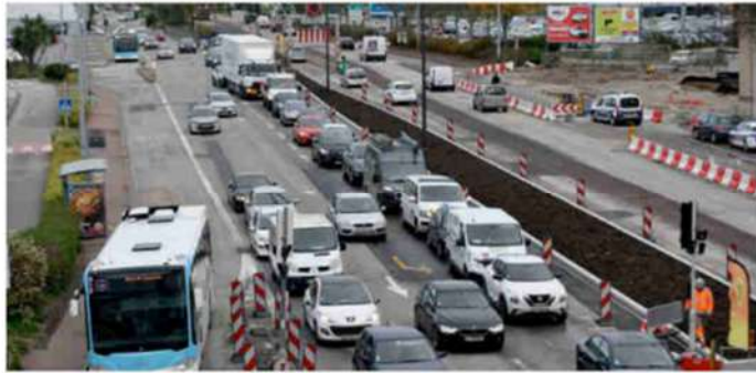
→ Au niveau de la gare, les trois voies de circulation dans le sens est-ouest ainsi que l'accès direct au tunnel sont rouverts depuis hier.
