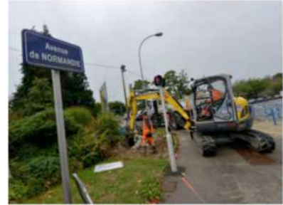
→ Avenue de Normandie. Du 29 août au 14 septembre : chaussée rétrécie au niveau du carrefour du boulevard de l'Atlantique et de l'avenue de Normandie. Un cheminement piéton est prévu le long du chantier.
