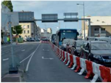
→ Quai Alexandre-III. Du 5 septembre au 22 décembre : travaux côté façades, avec trottoirs refaits aux normes PMR, création des futures places de stationnement et des futures voies routières.
