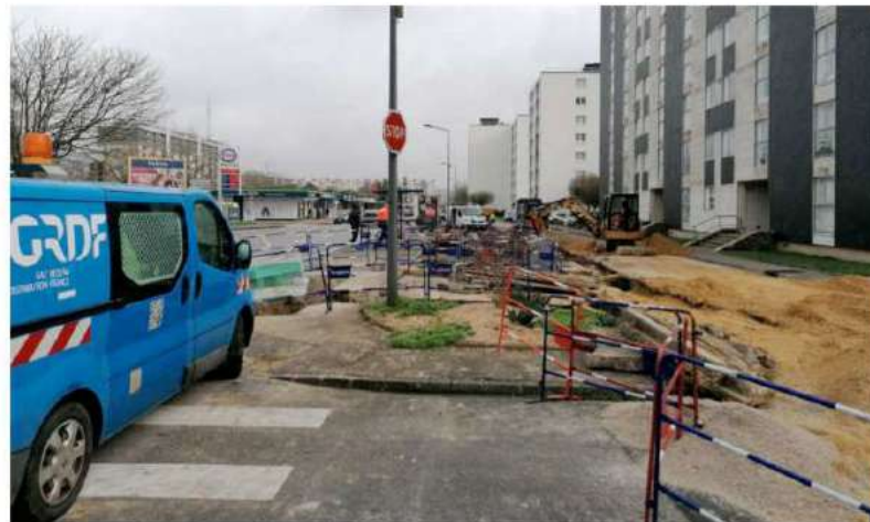
→ GRDF doit dévier le réseau de gaz en vue de l'implantation future d'une station du bus nouvelle génération.
