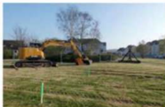
→ Les premières tranchées ont été réalisées dans un périmètre balisé par des barrières.
