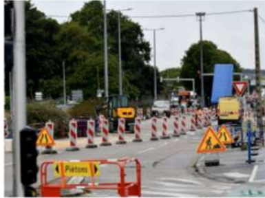
→ Arsenal - porte du midi. Du 5 au 26 septembre : le chantier sera mobile, travaux préparatoires de signalisation. Du 27 septembre au 16 décembre : travaux partie centrale, aménagement des futures voies dédiées aux bus.
