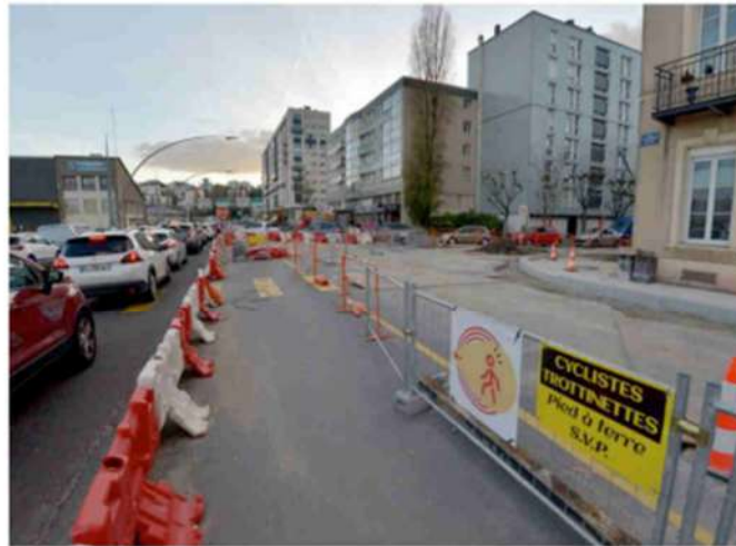
→ Les travaux du BNG seront suspendus du jeudi 22 décembre au mardi 3 janvier inclus. Quai Alexandre III, il sera possible de tourner à droite vers l'avenue Delaville et le parking Divette.
