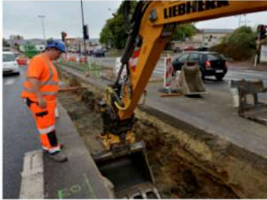
→ Quartier de la gare. Avenue Millet : chaussée rétrécie (du 5 au 27 septembre). Rue des Tanneries : chaussée rétrécie (du 5 au 27 septembre). Place Jean-Jaurès et rue des Tanneries : chaussée rétrécie (du 29 août au 2 décembre).
