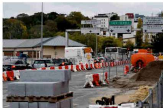
→ Serge Berthenet prévient : « Ne pensez pas qu'une fois les travaux terminés qu'il y aura un Alexandrie-III, ce sera mieux. Non ! Il n'y aura qu'une file comme maintenant. »
